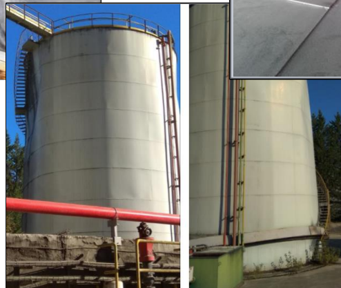
Ingeniería Forense. Análisis de Falla de Tk Almacenamiento API 650
